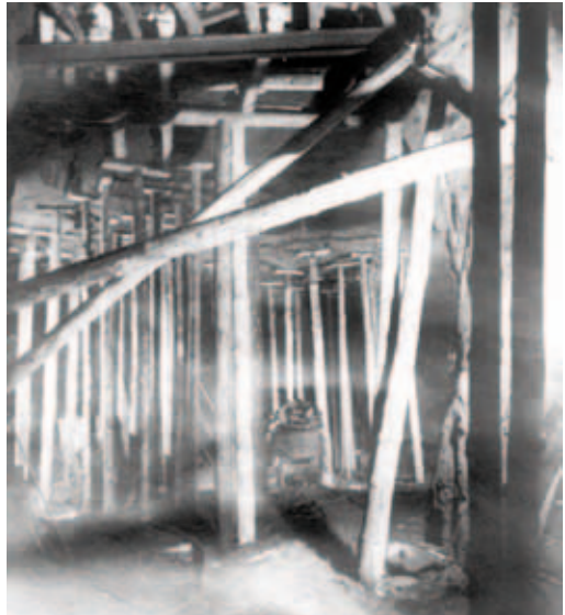
Holzausbau eines Stollens
